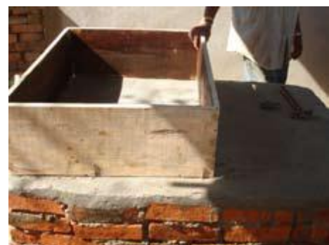
Imagen 6.- Armado de cajón (base).
